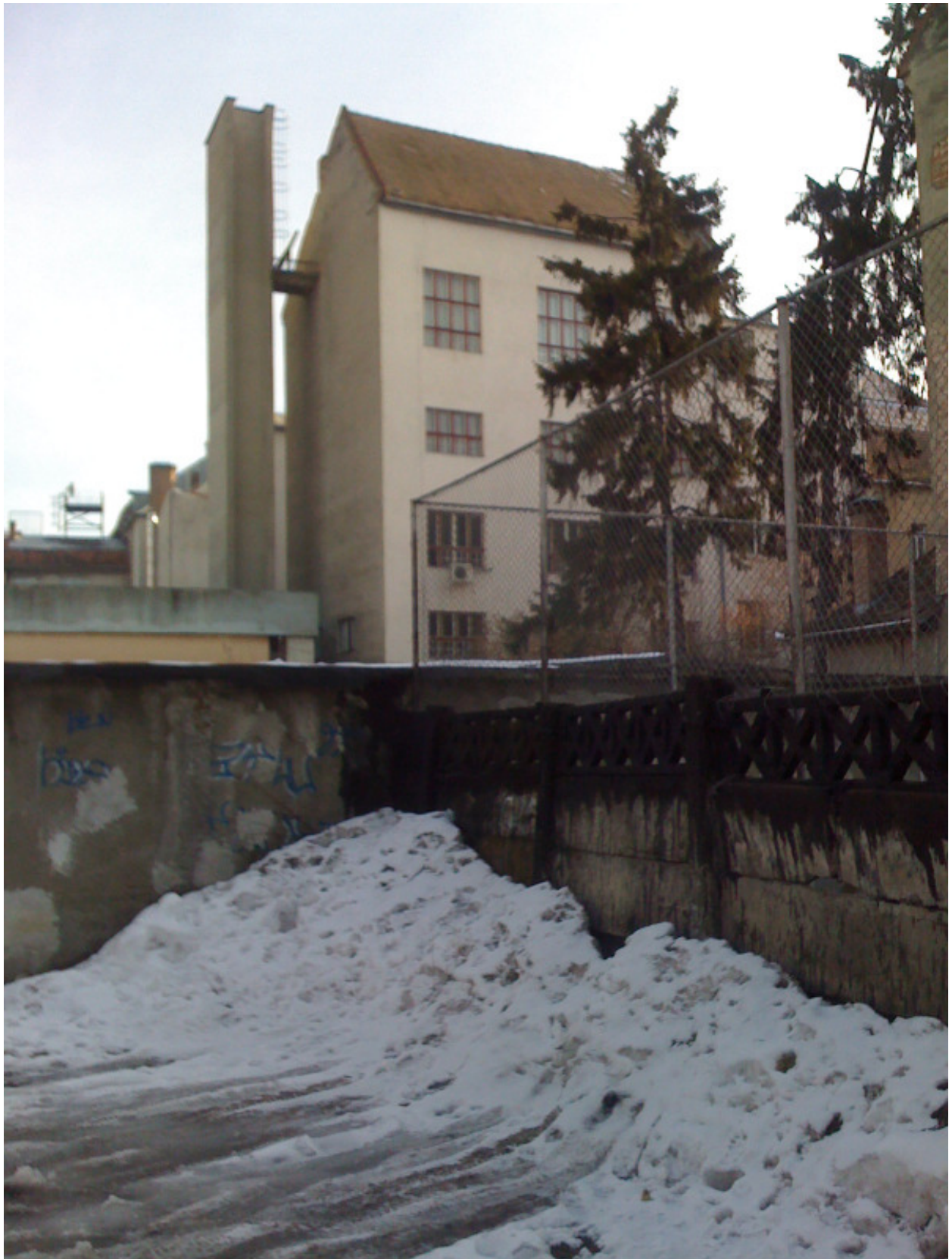
Coș de fum la centrala termică propusă pentru dezafectare
